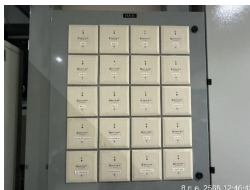
รูปที่ 3-22.1 แผงควบคุม (Fire Alarm Control : FCP) และ โมดูลควบคุม
