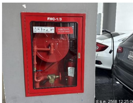
รูป 3-22.12 บันไดหนีไฟ ST1 กับ ST2 ตู้เก็บสายฉีดน้ำดับเพลิง
