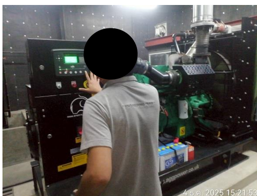
รูปที่ 3-30 เจ้าหน้าที่ตรวจสอบเครื่องกำเนิดไฟฟ้าสำรอง
