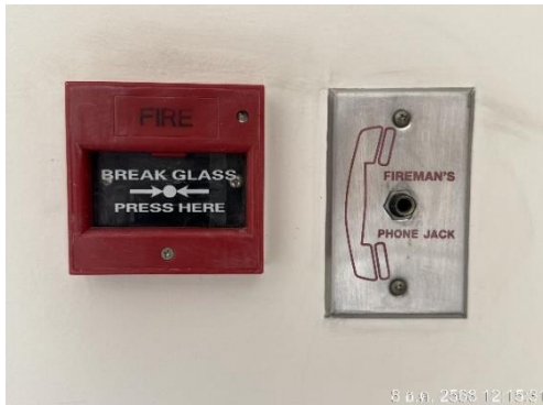
รูป 3-22.8 Manual Switch และ Telephone Jack
