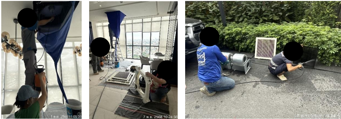
รูปที่ 3-23 ล้างเครื่องปรับอากาศและฟิเตอร์ส่วนกลาง
