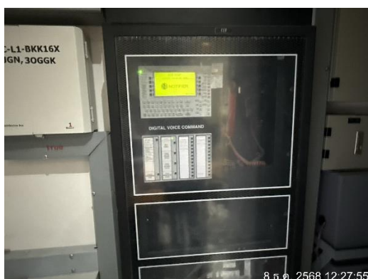
รูปที่ 3-22 ระบบป้องกันและเตือนอัคคีภัย
