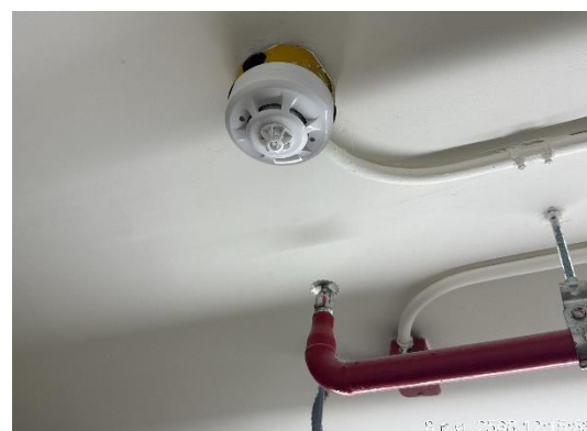
รูป 3.22.5 เครื่องจับความร้อนและสปริงเกอร์
